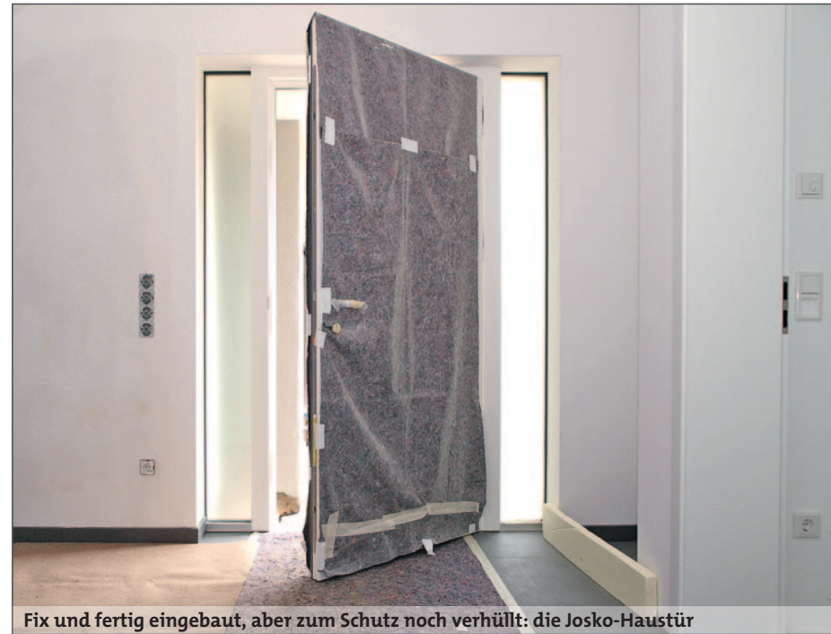
Fix und fertig eingebaut, aber zum Schutz noch verhüllt: die Josko-Haustür
